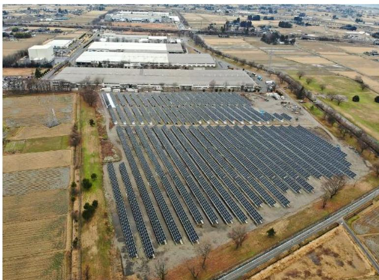
SMFL みらいパートナーズは、YKK AP の滑川製造所の東側遊休地に太陽光パネル 8,151 枚を設置し、発電した電力の全量を滑川製造所に供給します。パネル容量は 4,770kW、年間想定発電量 4,898MWh の電力を供給することが可能となり、初年度の二酸化炭素(CO<sub>2</sub>)排出量削減効果<sup>\*2</sup>は、約 2,146t となる見込みです。発電量は、滑川製造所の年間電力使用量の 23%に相当します。なお、SMFL みらいパートナーズのオンサイト PPA の発電容量で最大規模となります。
