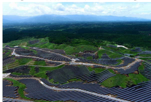
【JRE 山都高森第二太陽光発電所全景】
