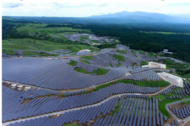
【JRE 山都高森第一太陽光発電所全景】
